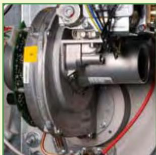
Высокая энергоэффективность благодаря модулирующей горелке
