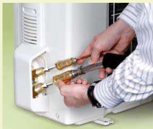
Простой монтаж благодаря быстроразъемным соединениям
