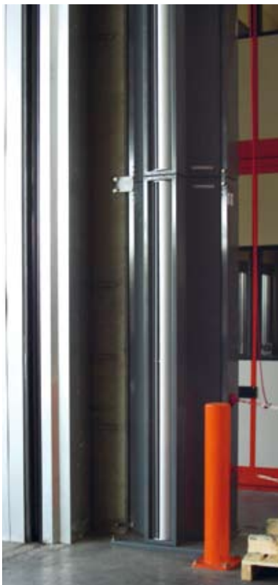
Установка RATIOVENT, смонтированная вертикально с двумя устройствами одно над другим. Запатентованная сопловая система EVOLVENT® экономит до 40% энергии по сравнению с установками обычного щелевого типа.
