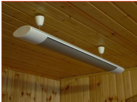
Рис. 3. Инфракрасный обогреватель.
